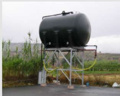
Tanques Metálicos Elevados
